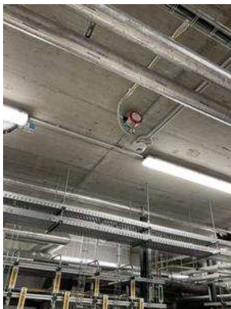
Obrázek 4: Detekce úniku H 2 , řídicí ústředna systému
