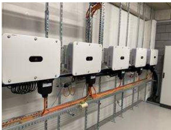
Obrázek 9: Střídače FVE
