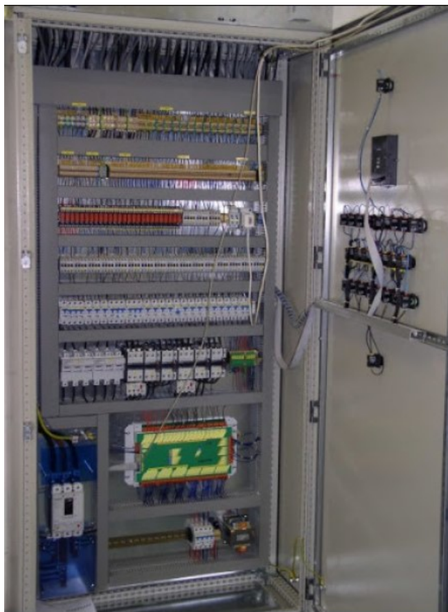
Ilustrační obrázek rozvaděče pro napájení a MaR technologii
