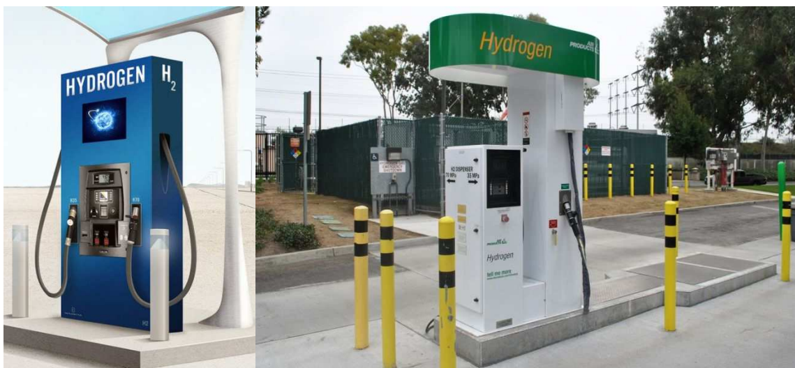
obr. 10 Příkladové provedení výdejního stojanu pro výdej vodíku
