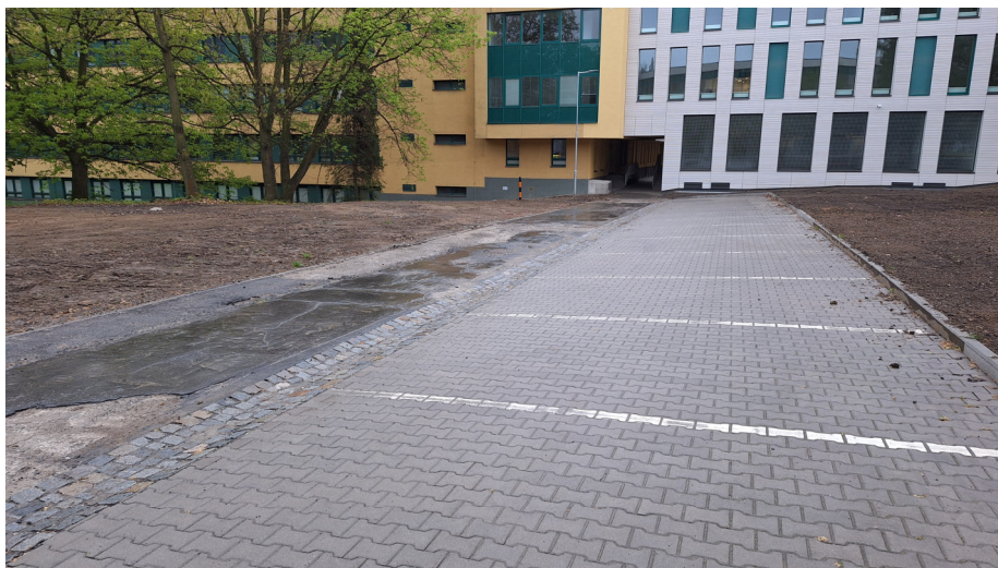
Prostor určený pro zařízení staveniště.
