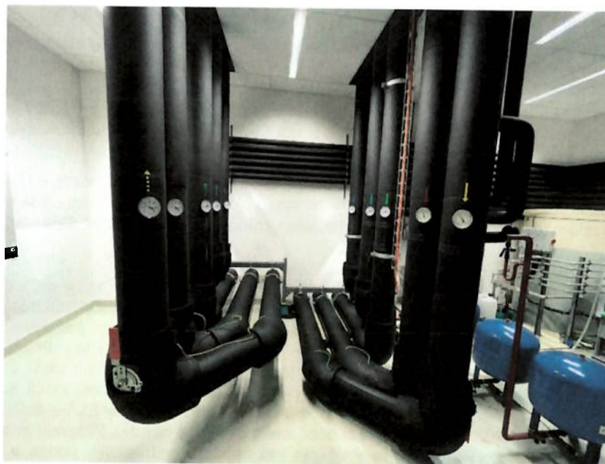
Obrázek 3 - Přívod páteřního potrubí do sálu
