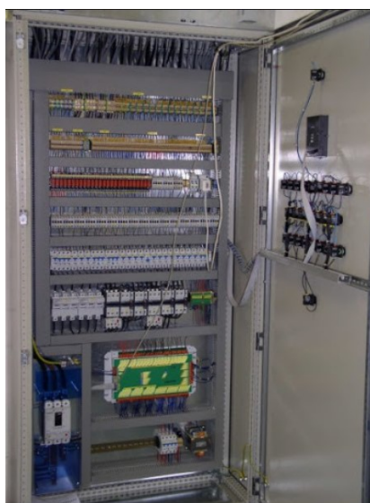
Ilustrační obrázek rozvaděče pro napájení a MaR technologií a obrázek záložního napájení UPS
