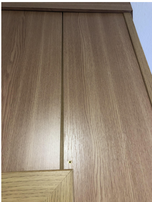
Detail spoje a kotvení vrtem opláštění příčky.
